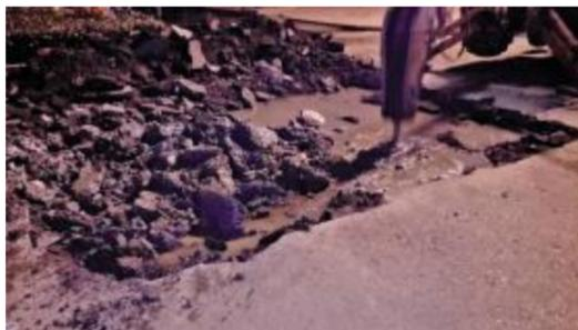
经过多方协调,终于在凌晨5点钟将挖机调到现场,并通知电力、燃气及通讯公司到现场确定是否有其管线,防止开挖时造成的二次损害。在开挖过程中,由于我们的大型蝶阀不能完全关闭,所以漏水量还是很大。为了控制局面,新海管线路所动用两台六寸泵和一台四寸泵进行强排。经过5个多小时开挖,时间已到中午11点钟,开挖将近3米多,才终于找到了供水管道。
