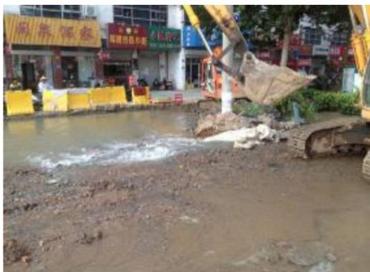
大。抢修开挖后不断地出现各种状况,打好的桩多次塌方,现场紧急制定严谨可行的抢修施工方案,调剂20根12米长的槽钢及专用打桩机进行深基坑围护。历经30多个小时奋战,爆裂管道抢修完毕。由于该管道的是向东部城区输送自来水的主管线,加之东部城区个别地方地势较高,全部恢复供水需要4天的时间,在炎热的夏日,给用户带去的不便可想而知。
