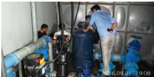
二次供水管理部秦副部长第一时间赶赴现场指挥泵房抢险工作。根据现场实际情况,与维修班长一起商讨制定了泵房抢修及临时恢复供水方案。确定了以现有水箱底层1米为高度,打孔安装遥控浮球阀,进行水位控制,临时恢复泵房供水。从18时开始,停中、高区供
