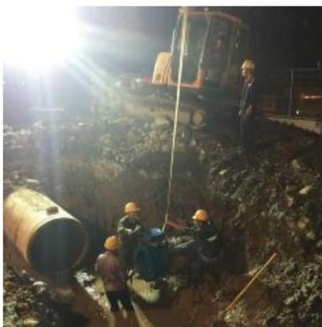
310国道改线工程是为配合连盐铁路建设,将连盐铁路两侧原DN800管线改为南侧DN1000管线、北侧DN800管线的工程,整个工程需安装DN1000球管150米,DN1000钢管192米,DN800钢管204米。由于310国道南侧铁路东侧管埋深约4米,改管管材为壁厚12mm钢管,施工方案相当复杂,施工难度大大增加;同时,改线工程与铁路建设存在多项交叉作业工作,导致改线工程无法连续作业。为保证项目工期,源通人面临时间紧、难度大、任务重、协调难度大等多重压力。
