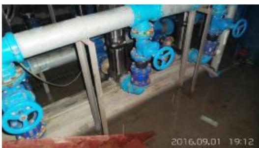
水,只保留低区供水,进行浮球阀安装作业,19时20分左右,浮球阀安装完毕,恢复整个小区供水,保证了小区居民的用水需要。
